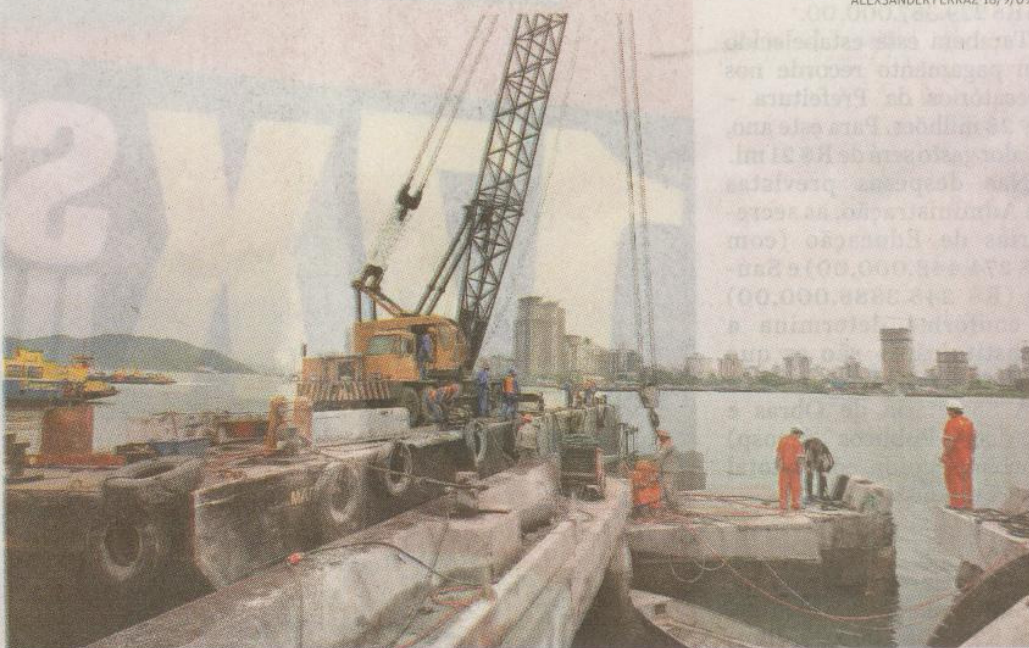
O atracadouro de balsas atingido por um navio em julho deve ser recuperado até o início da temporada
